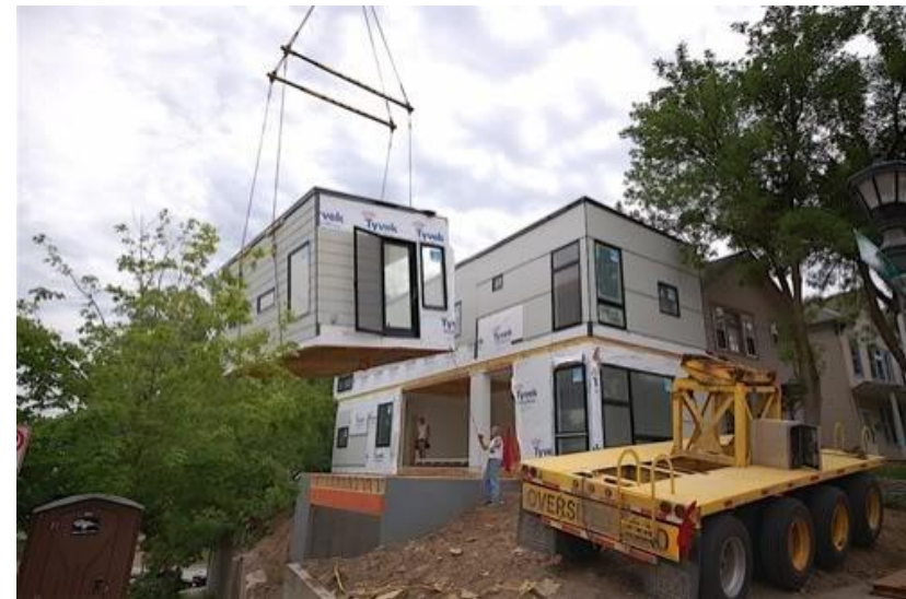
Fig. 38 Vivienda modular de fácil desmontaje y armado.
