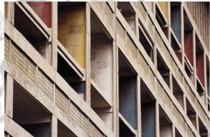
Imagen 33: Marquesinas de concreto. Fuente: http://arkinetia.com/articulos/los-caminos-de-le-corbusier_a383/ Fecha de Consulta: 20/02/2015
