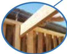
Las vigas de madera se encastran y atornillan a las placas laterales para trabajar físicamente sobre el peso de la estructura. Se colocan durante el cuarto día y sirven para sostener el techo de chapa zinc.
