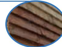
Las paredes de la casa están compuestas por **placa de madera** recubiertas con impermeabilizante. Son clavadas y atornilladas para dar una mayor seguridad y resistencia.
