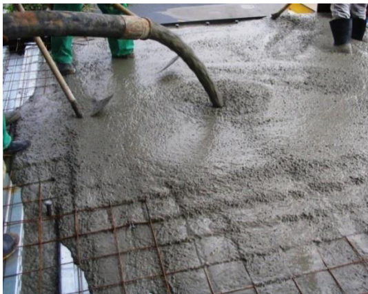
FIG. 7, CEMENTO , (2011), fundición de losa reforzada con electromalla, tomado de: http://optimusengenharia.com.br/?attachment_id=82
