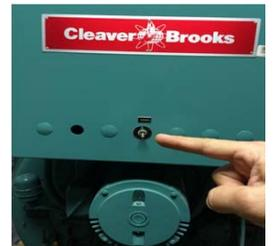
B Apagar el interruptor de la bomba de agua. Regresar a la posición central.
